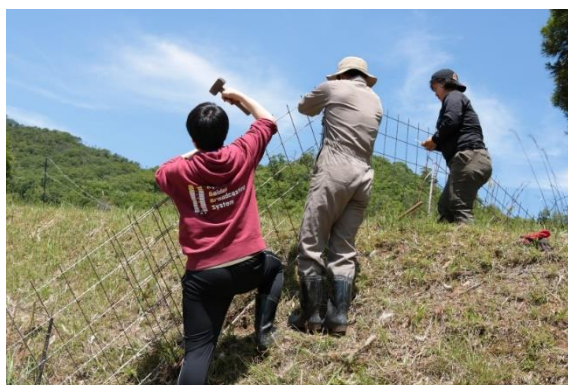
写真 10 古熊谷での獣害柵の設置作業
